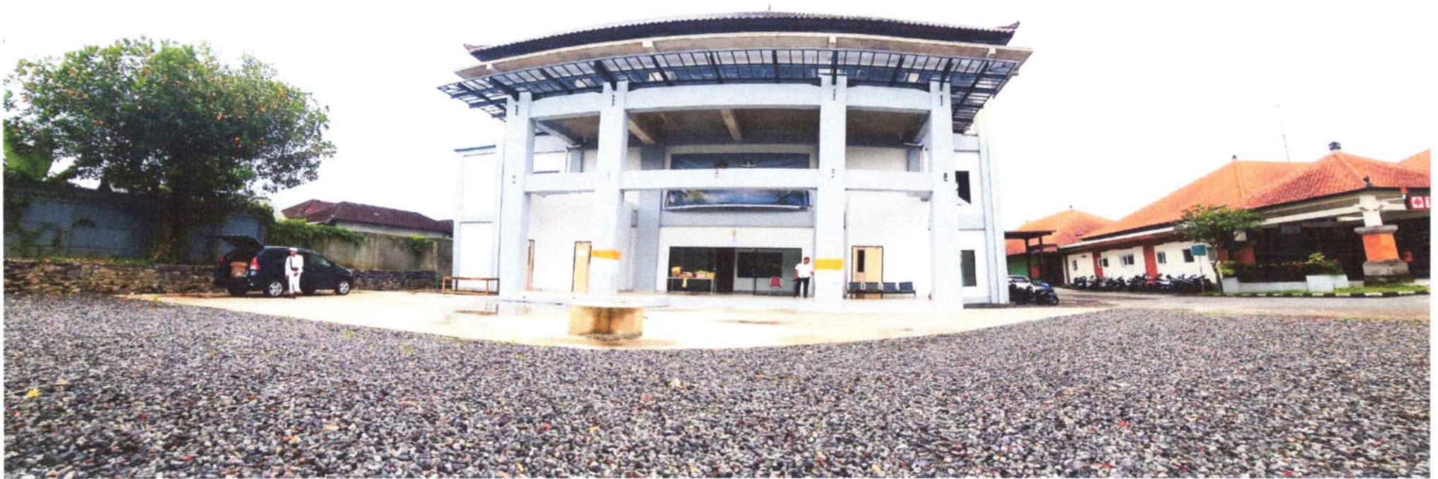
*Dokumentasi Pembangunan Gedung Napza
